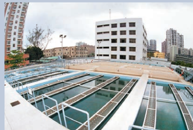
Water Plant 水廠
